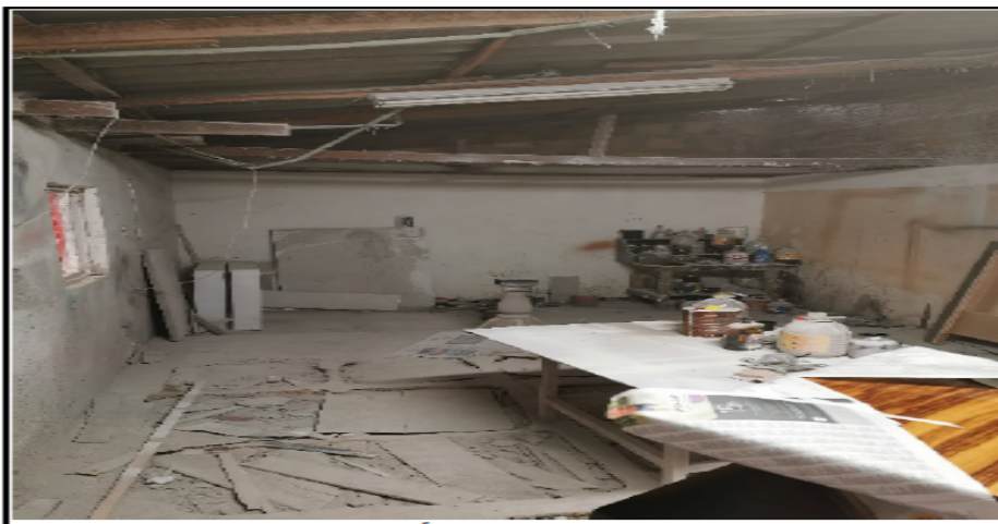
FOTO 5. ÁREA DE PINTURA
