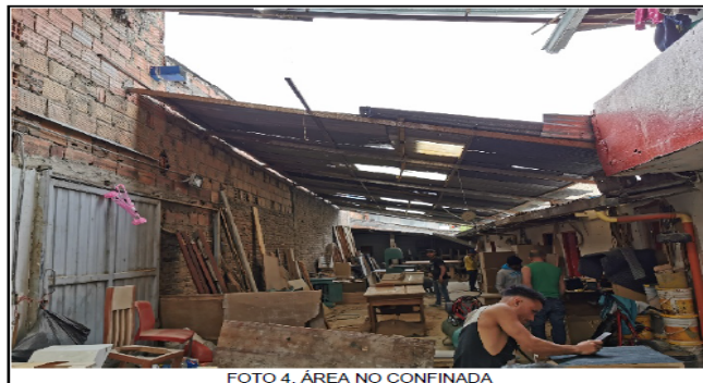
FOTO 4. ÁREA NO CONFINADA
